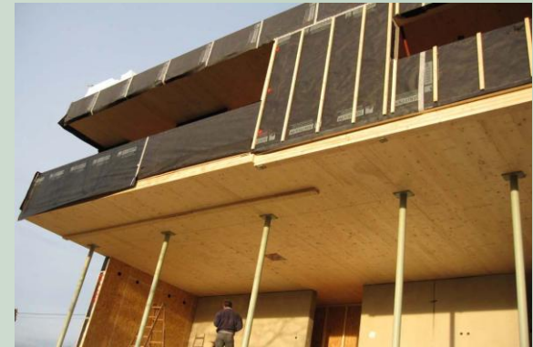
punktgestützte (Stahl- oder Holzstütze) BSP-Platte
